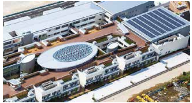
広島特別支援学校の屋上に設置された太陽光発電システム
