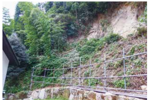
急傾斜地崩壊対策事業 (対策前)
