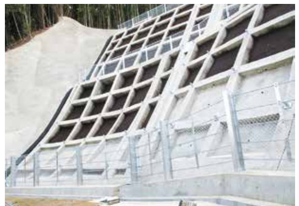
急傾斜地崩壊対策事業 (対策後)
